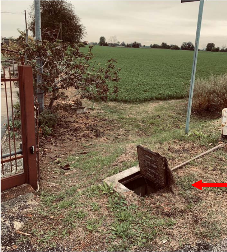
Vista 9 – Via Stradone: collegamento alla rete fognaria
