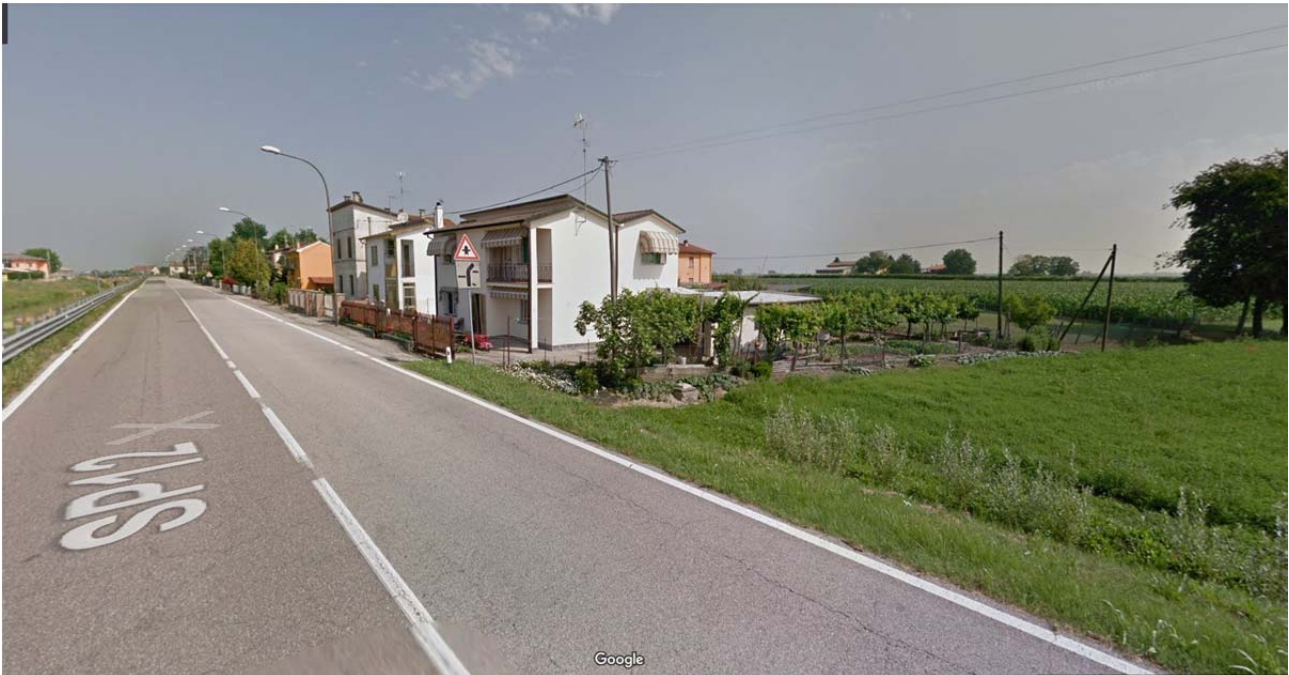
Vista 7 – Via Stradone direzione sud-nord nella parte finale dell’ambito d’intervento
