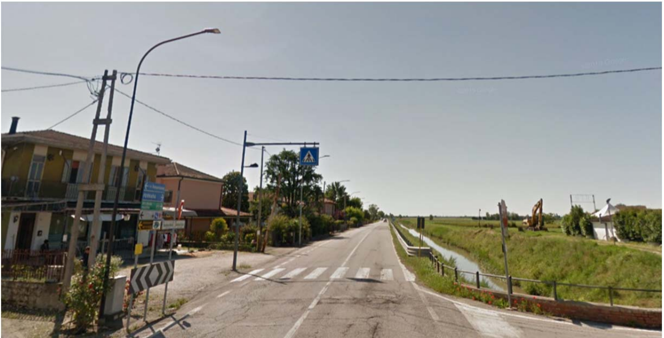
Vista 3 – Via Stradone direzione nord-sud in prossimità dell'attraversamento pedonale esistente che risulta poco visibile nonostante sia evidenziato con segnaletica verticale retroilluminata
