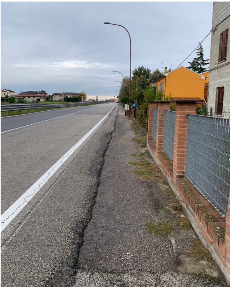
Vista 10 – Via Stradone: banchina laterale in prossimità delle abitazioni
