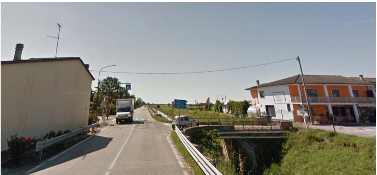
Vista 2 – Via Stradone direzione nord-sud in prossimità dell'ingresso a Piazza Runzi
