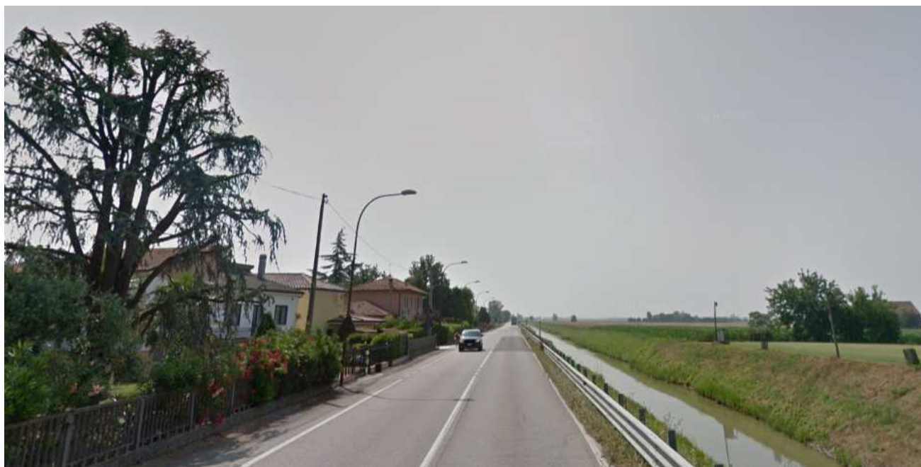
Vista 4 – Via Stradone direzione nord-sud
