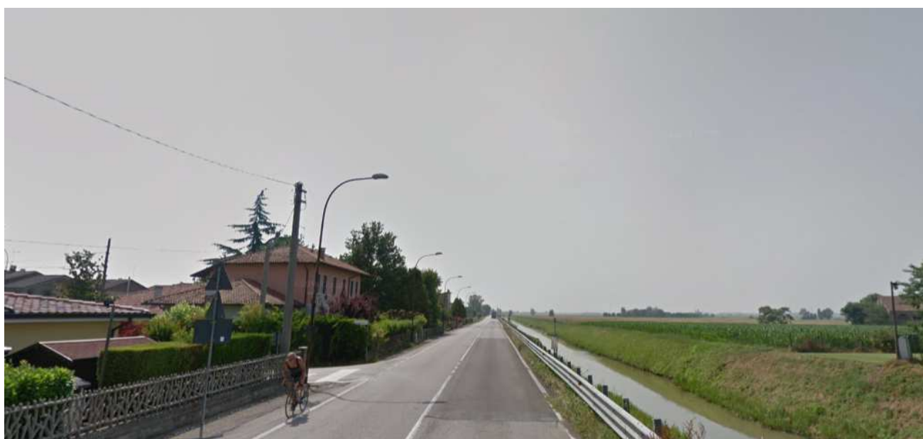
Vista 5 – Via Stradone direzione nord-sud in corrispondenza con l'intersezione di via Pellizzare
